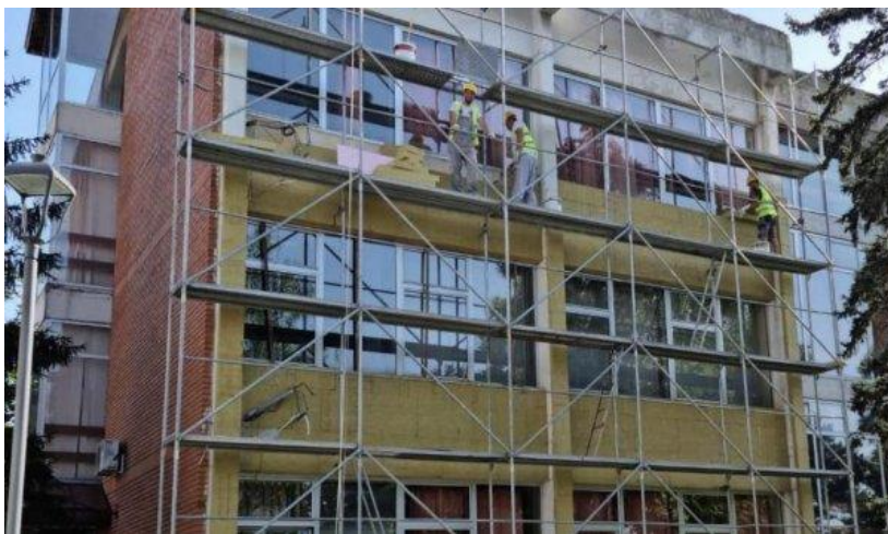
Slika br.5 -Radovi na objektu gimnazije “Vuk Karadžić “ u Trsteniku
